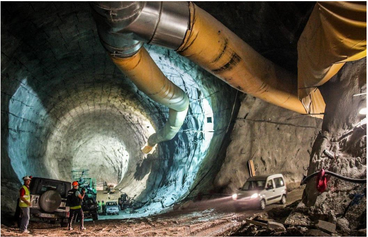
DESARENADOR SUPERIOR – fase final da escavação
