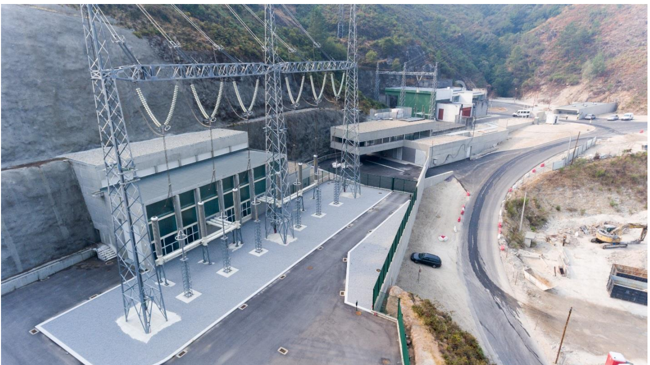
EDIFÍCIOS EXTERIORES - fase final da construção dos edifícios
