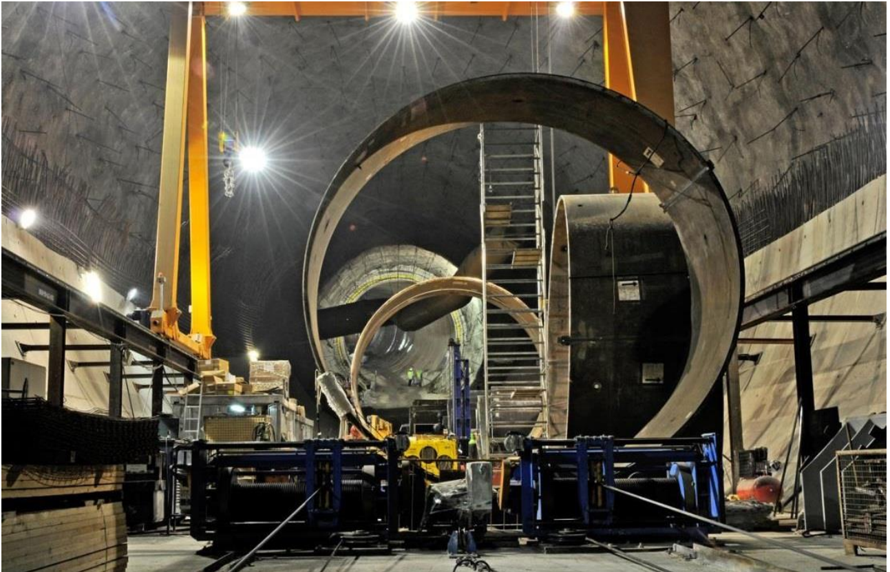
DESARENADOR SUPERIOR – montagem de blindagens e execução de betões
