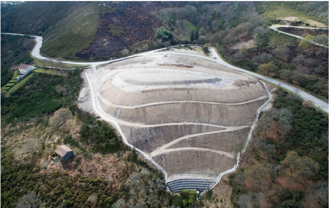
ESCOMBREIRAS – modelação final da escombreira de montante
