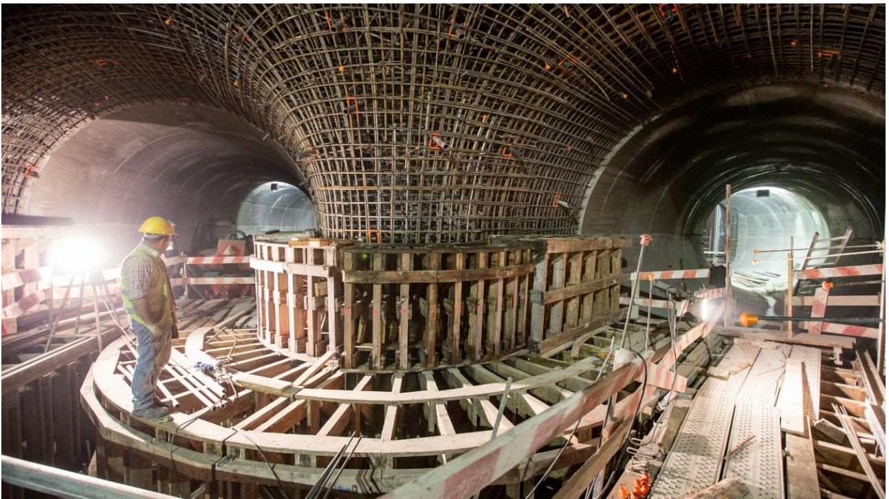
TRECHO INFERIOR DA CENTRAL - montagem de cimbra da bifurcação
