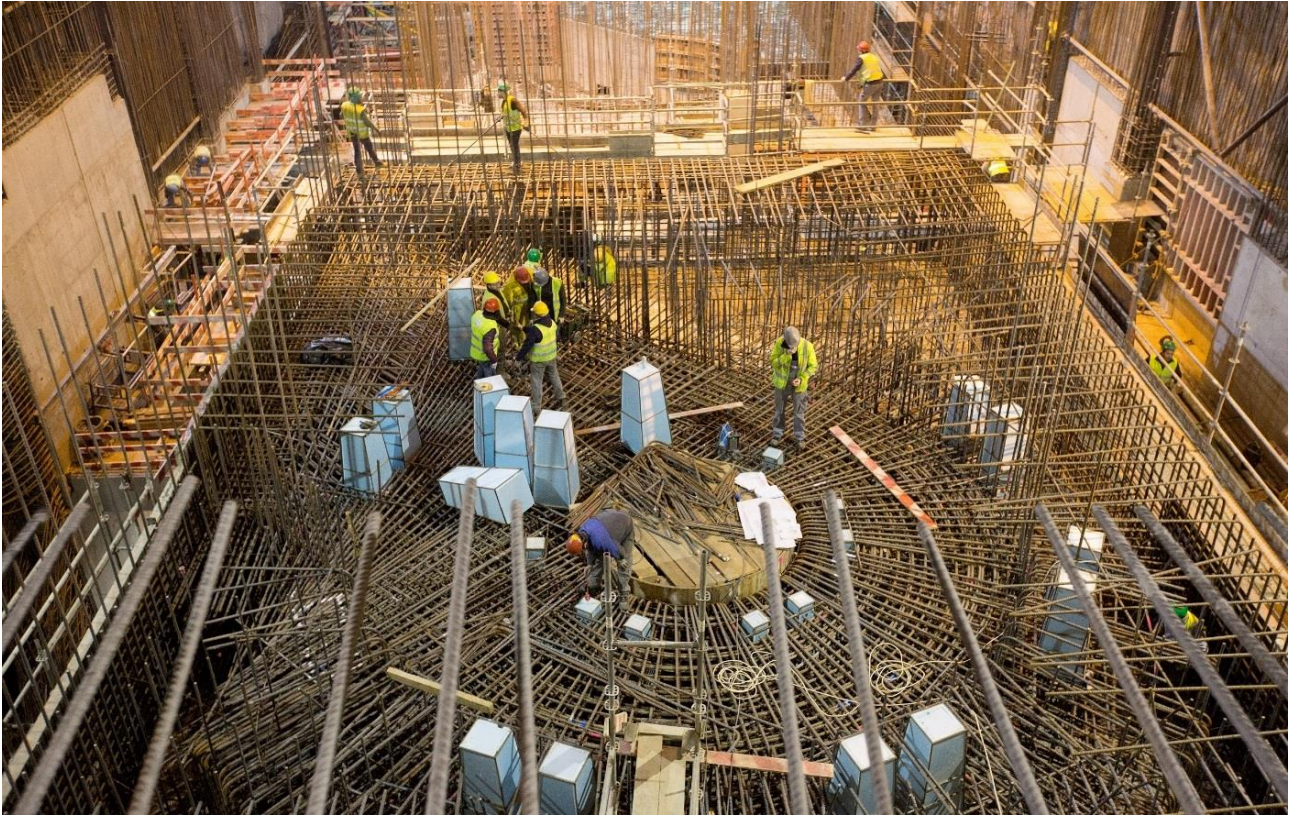
CENTRAL - montagem de armaduras da fundação do alternador do Grupo 1
