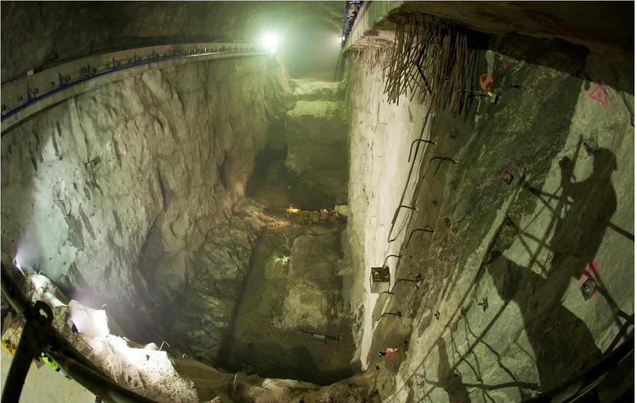
CENTRAL - fase final da escavação da Central
