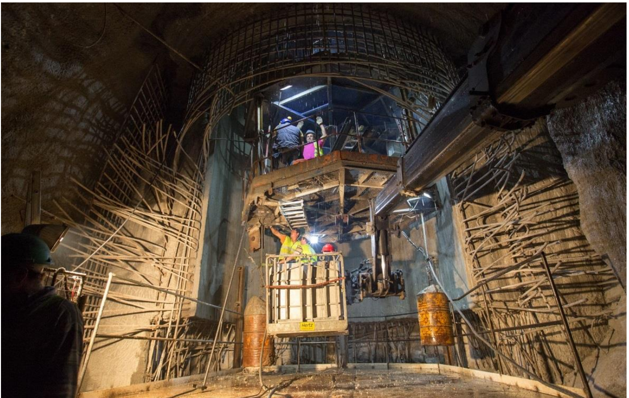
CHAMINÉ DE EQUILÍBRIO SUPERIOR - em curso betões de revestimento da zona de falha do poço 2
