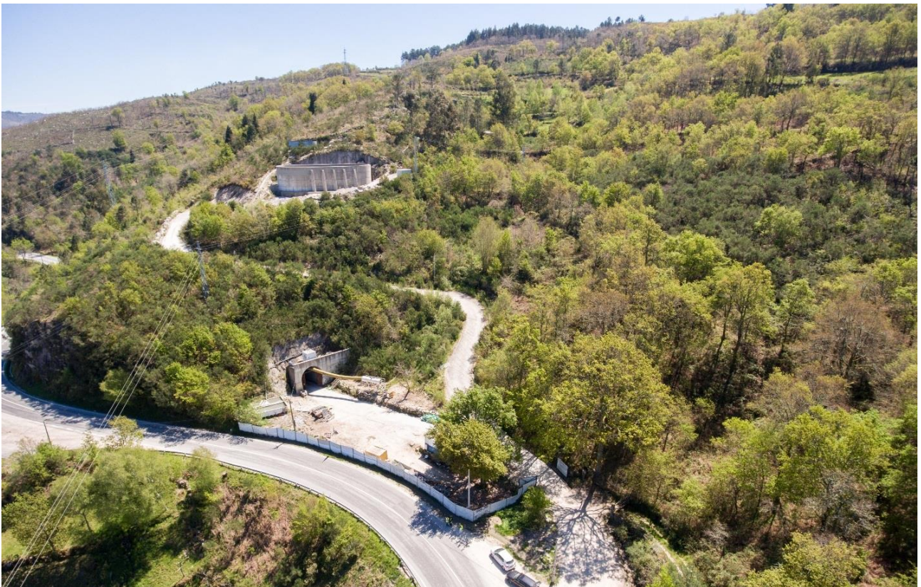
CHAMINÉ DE EQUILÍBRIO SUPERIOR - câmara de expansão
