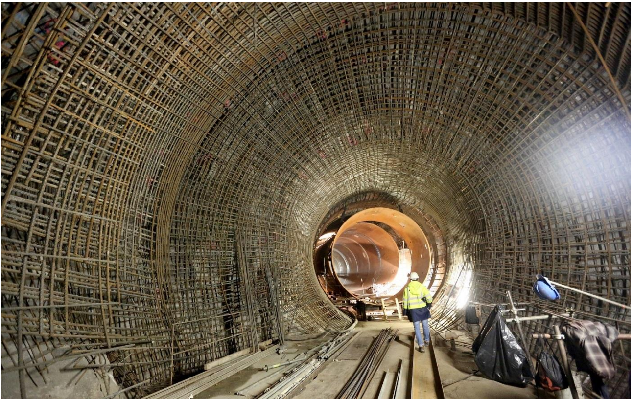
RAMAIS EM CARGA - montagem de malha exterior nos ramais em carga antes do posicionamento das virolas
