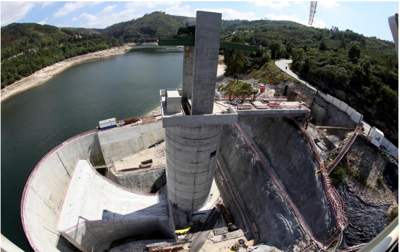
TOMADA DE ÁGUA - fase final de conclusão dos betões
