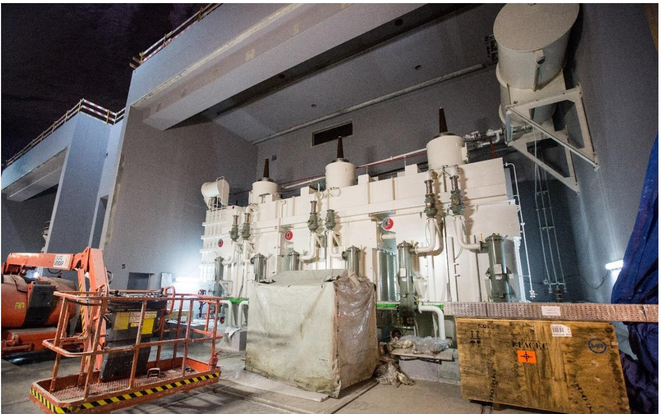
CENTRAL – montagem do transformador principal do Grupo 2
