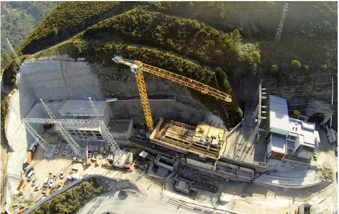
EDIFÍCIOS EXTERIORES - betões da cobertura do edifício de apoio
