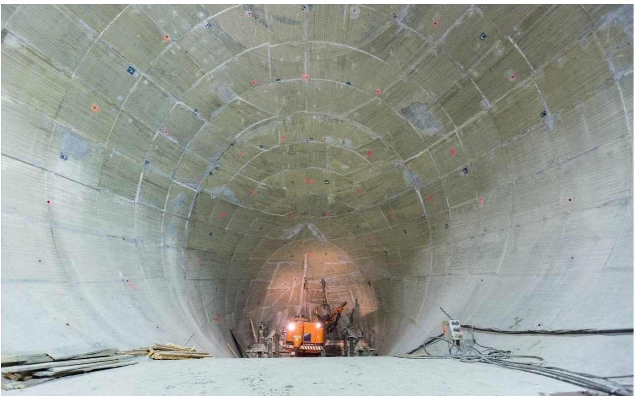
DESARENADOR SUPERIOR - trabalhos de injeções do troço variável de jusante
