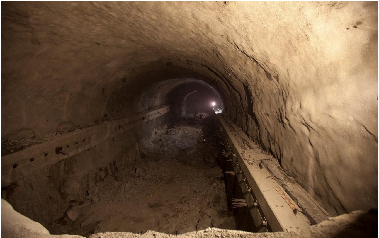
CENTRAL - em curso escavação da Central
