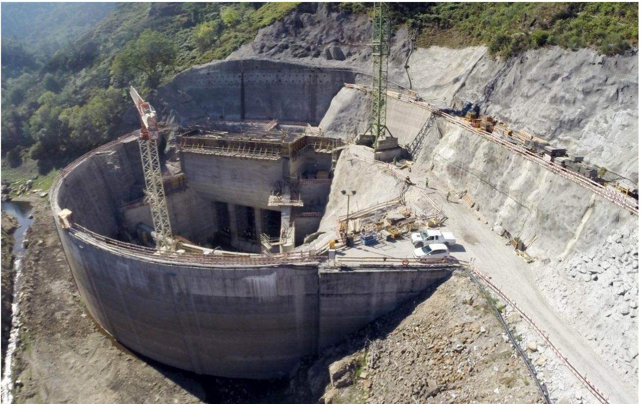
RESTITUIÇÃO - conclusão dos trabalhos do bocal da restituição ao abrigo da ensecadeira
