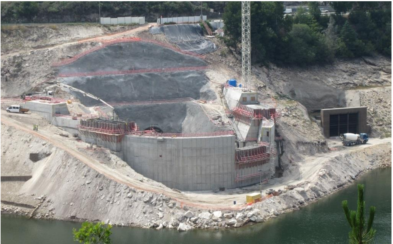
TOMADA DE ÁGUA - Fase final da construção da ensecadeira
