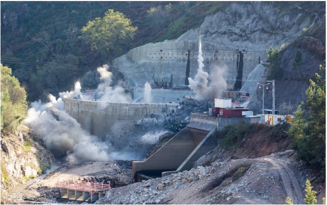
RESTITUIÇÃO - demolição da ensecadeira da restituição
