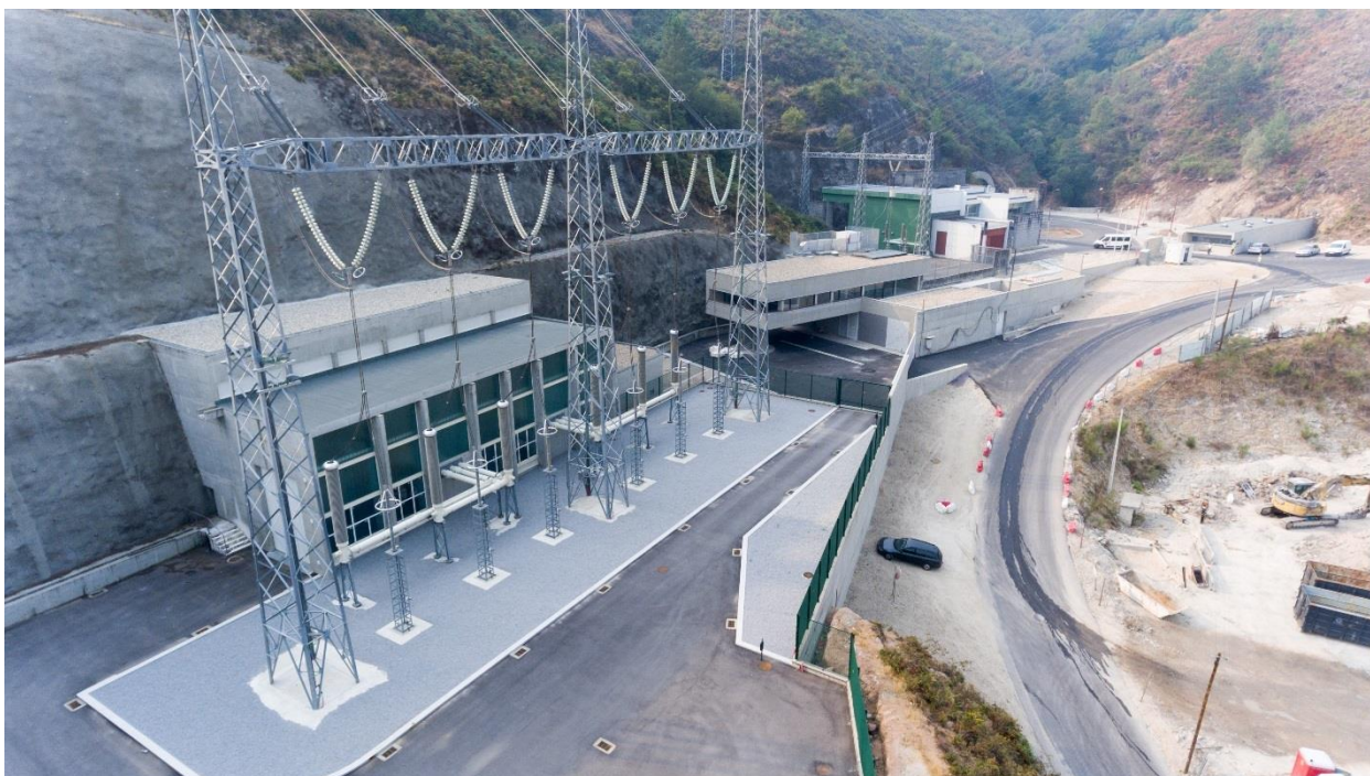
Figura 12 – Edifícios exteriores e plataforma de saída de linhas (fotografia aérea)
