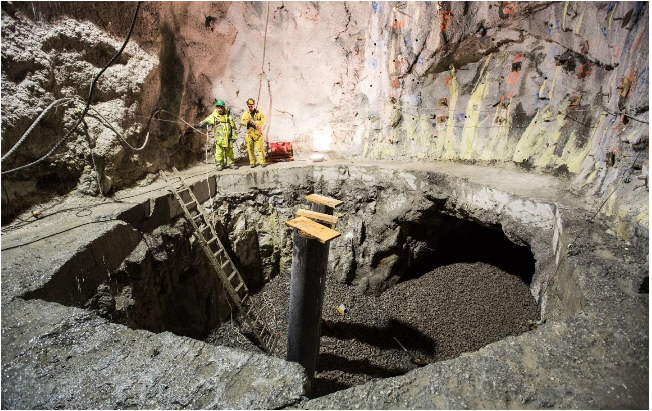
CHAMINÉ DE EQUILÍBRIO SUPERIOR - conclusão do enchimento do poço 3 para posterior tratamento da falha
