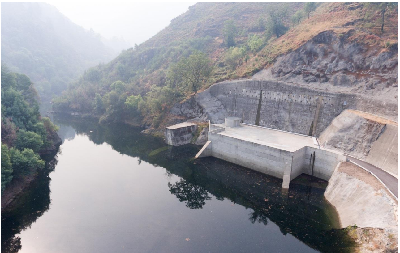
RESTITUIÇÃO - demolição da ensecadeira da restituição
