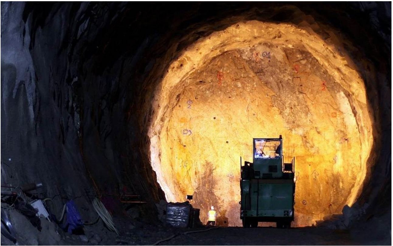
TÚNEL EM CARGA - em curso furação na frente de jusante
