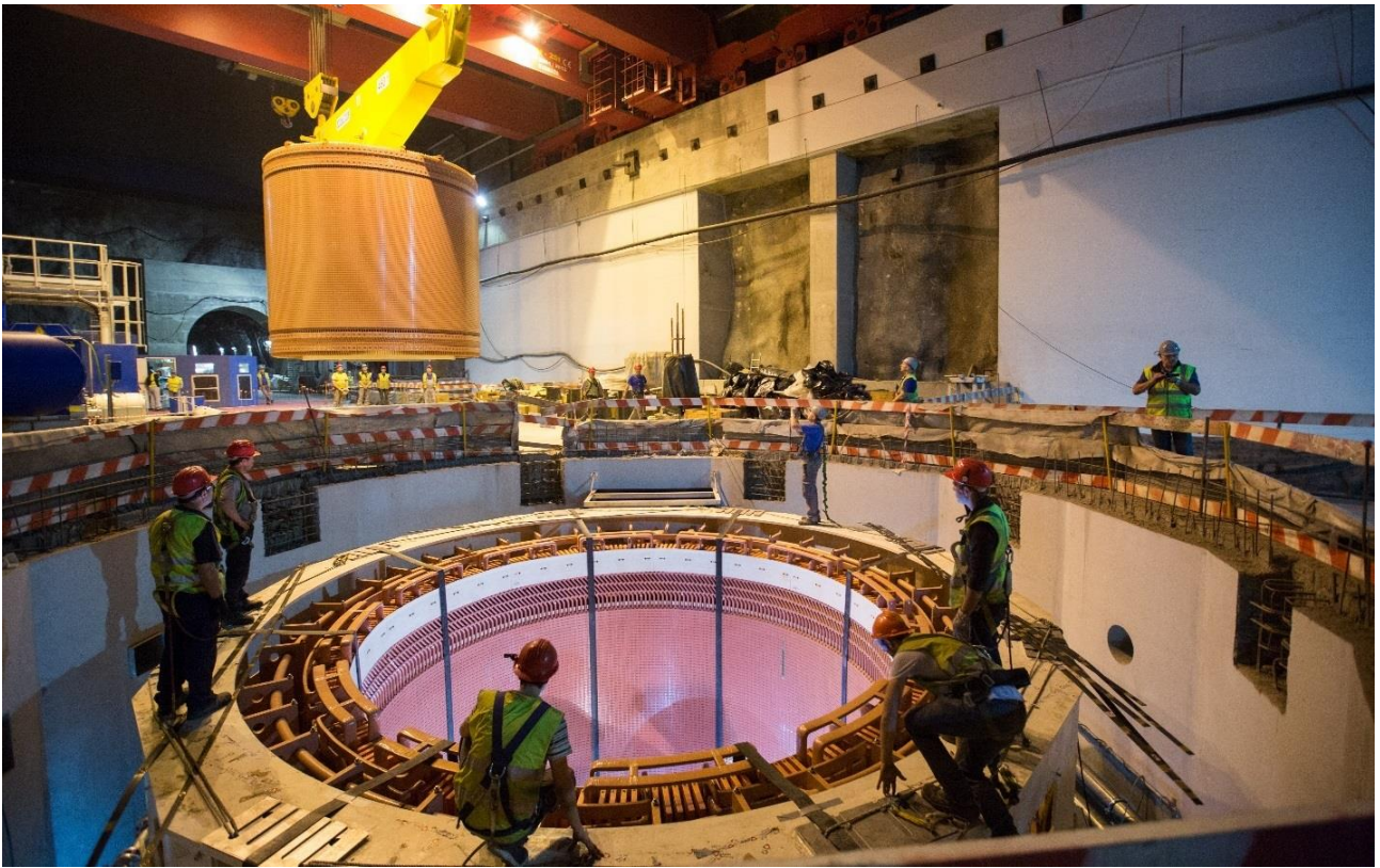
CENTRAL – transporte do rotor do Grupo 2 para o poço do alternador
