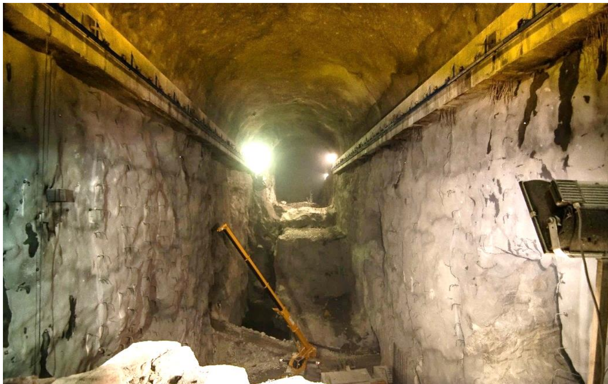
Figura 25 - Fotografia do interior da caverna dos grupos e da câmara dos transformadores no final das escavações
