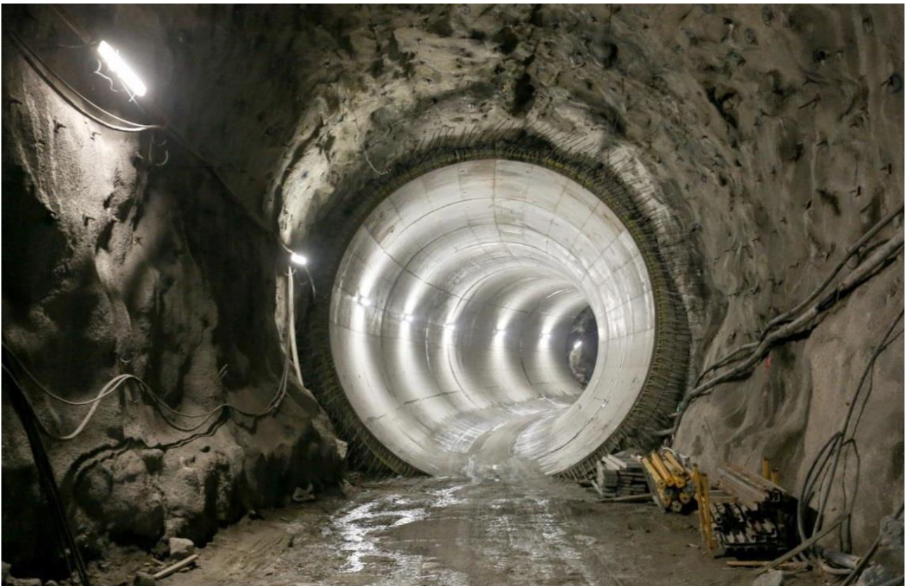
TÚNEL EM CARGA - secção revestida
