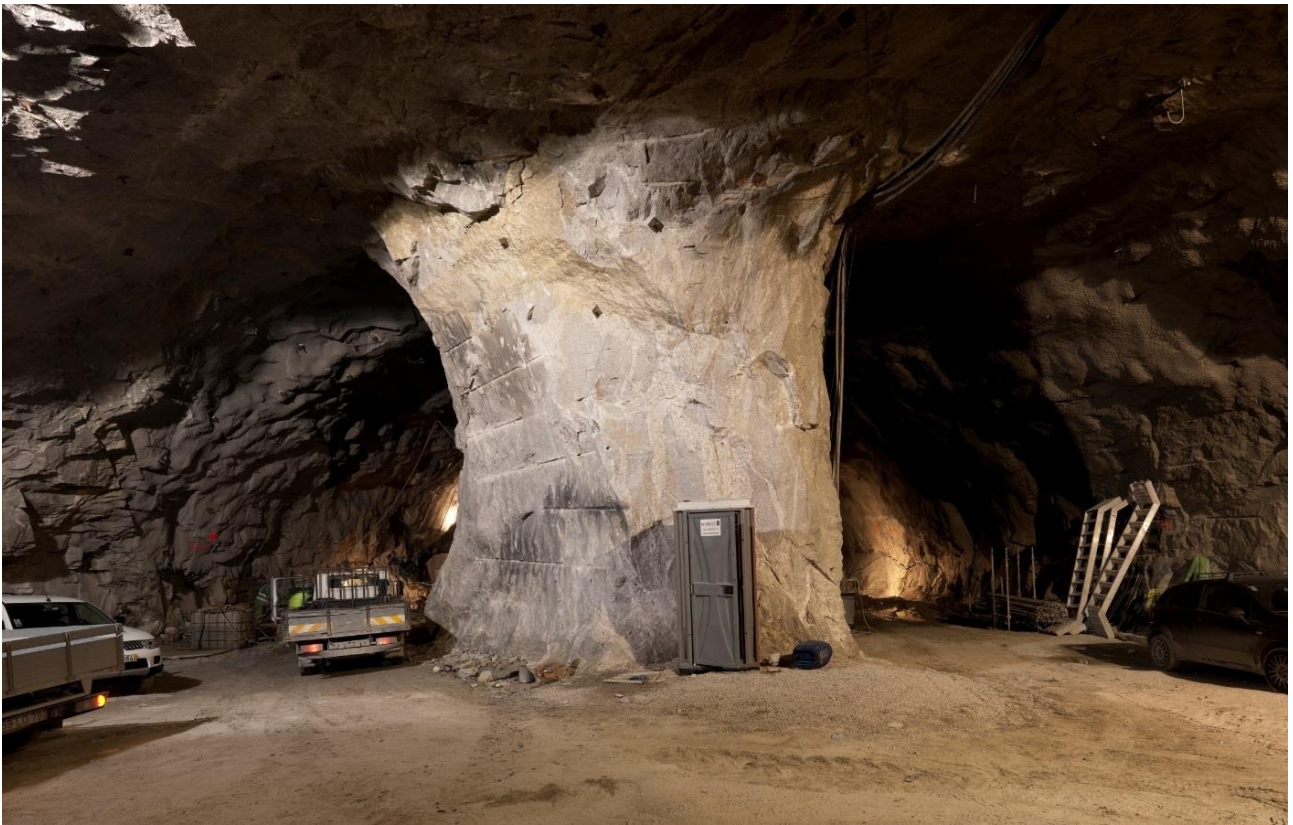
CENTRAL - colocação de extensómetros de varas na abóbada
